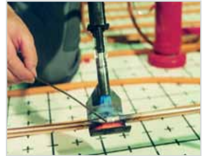
Bild 8.1 Herstellen einer Hartlötverbindung in einer Kupferrohr-Fußbodenheizung (2657)
