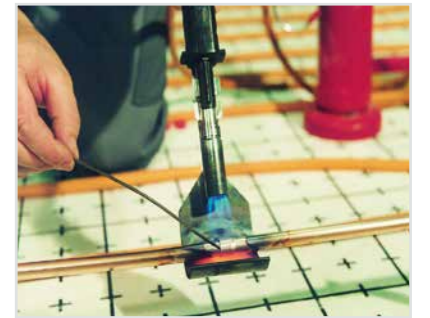
Bild 8.1 Herstellen einer Hartlötverbindung in einer Kupferrohr-Fußbodenheizung (2657)
