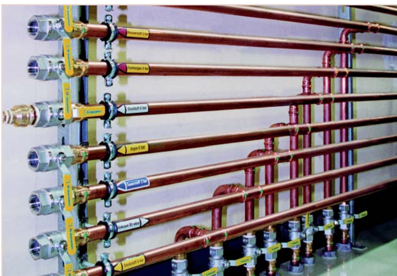
Bild 8: Verteilanlage für technische Gase, erstellt mit PressfitTINGS (DKI 6025)
