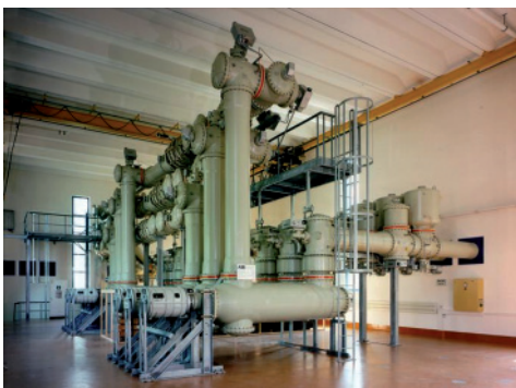
Bild 1: Gekapselte gasisolierte Schaltanlage bis 550 kV
