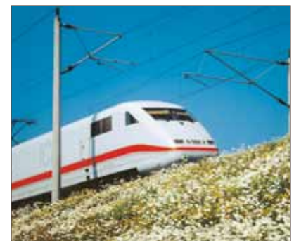
Bild 10: Fahrleitungsdraht für Hochgeschwindigkeitszüge
