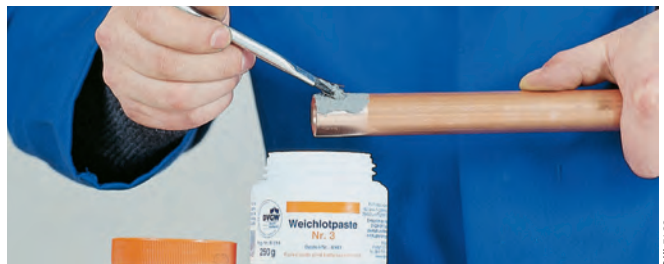
Flussmittel bzw. Lotpaste auftragen
