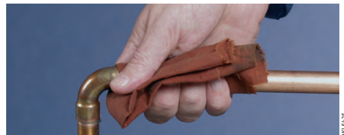
Flussmittelreste entfernen
