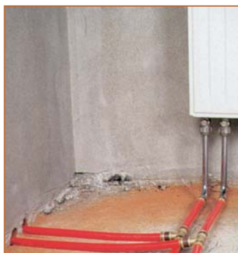
Anschlussgarnitur aus verzinktem Stahlrohr (oben: Einbaubeispiel)
