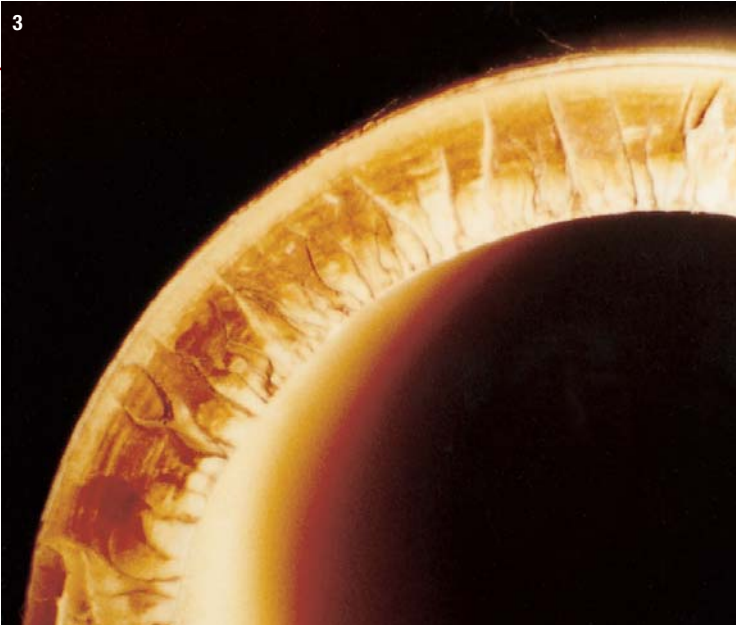
Bild 3 • Dauerbruch-Rastlinien an der PVC-C-Rohrbruchstelle
